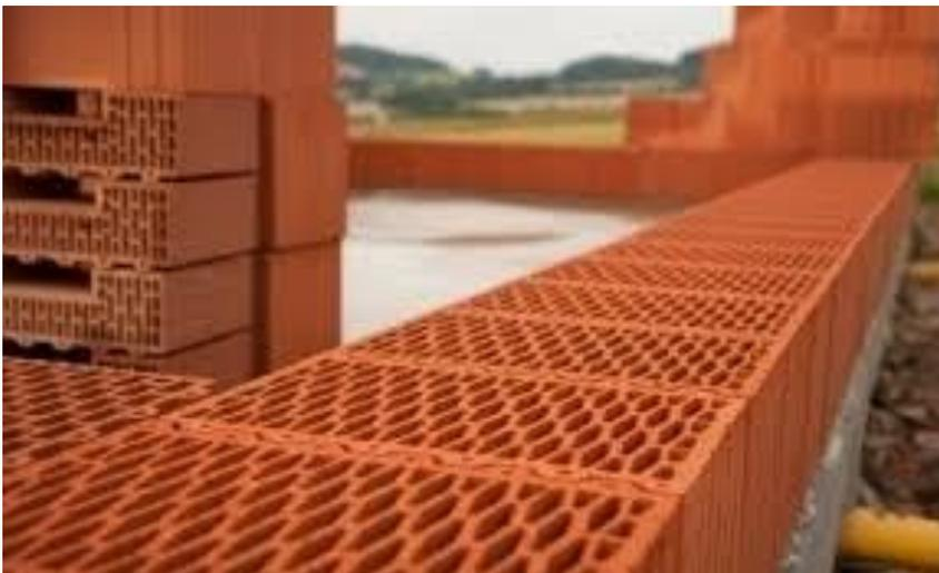
Le murature in elevazione perimetrali saranno realizzate con il sistema a blocco con isolamento esterno a cappotto. Costituiti da blocchi di laterizio portanti microporizzati tipo ALVEOLATER CLASSE 45 spessore 25 cm all'esterno compreso rinforzo lato interno e isolamento termico pannello di EPS alta densità secondo il calcolo risparmio energetico (L. 10/91) ma definito approssimativamente intorno a 14
