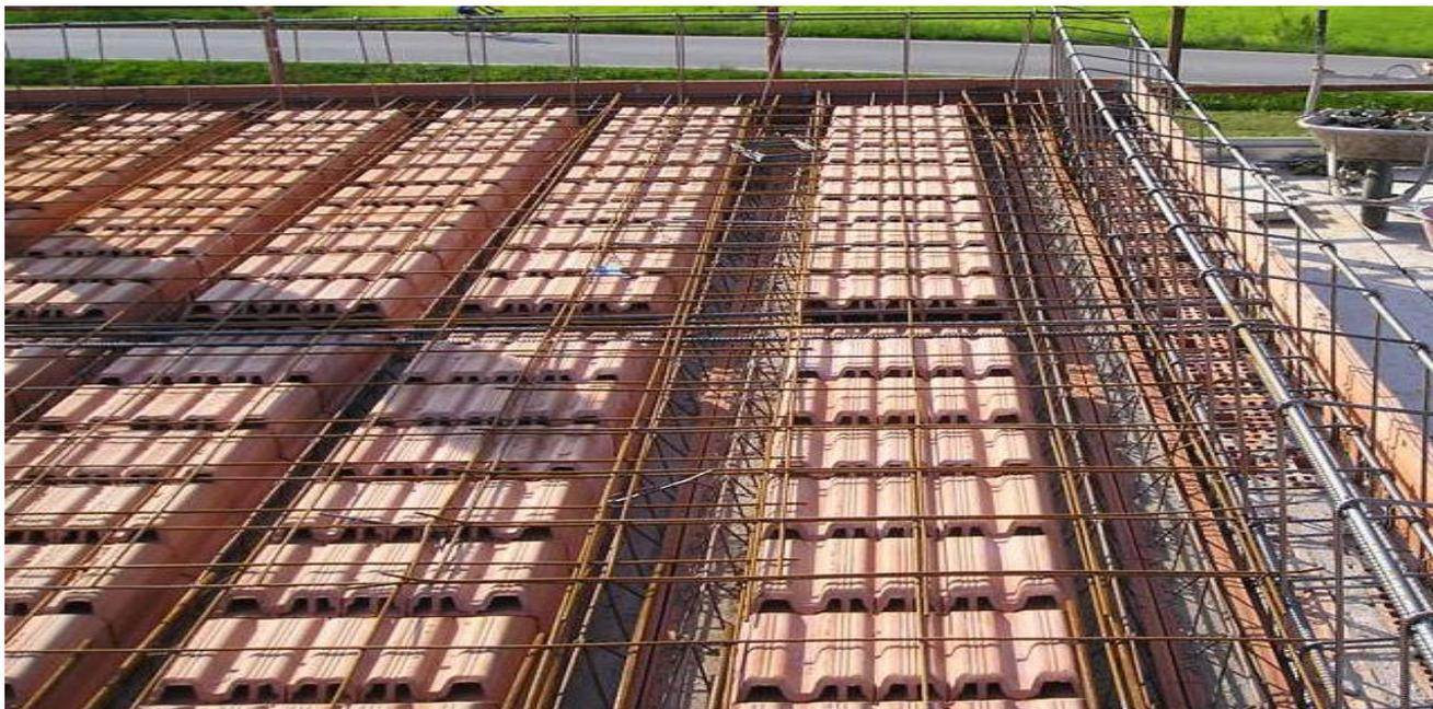
I solai interpiano saranno realizzati con travetti prefabbricati a traliccio (in cotto) con interposti elementi in cotto di alleggerimento e relativa Caldana in CLS (Rck200 Kg/cmq.) sp. minimo 4 cm. Spessore finito come da calcolo di C.A. Compreso l'onere per i ferri, corree perimetrali, travi piastre e ogni altro onere per la realizzazione di solaio con sovraccarico accidentale e sovraccarico permanente da calcolo C.A.
